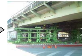
サ.【橋桁のずれ(鹿島線 延方～鹿島神宮間) 復旧前
