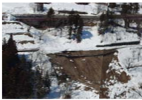
ス.【盛土流失(飯山線 横倉～森宮野原間) 復旧前
