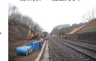
復旧後(4/1施工完了)
