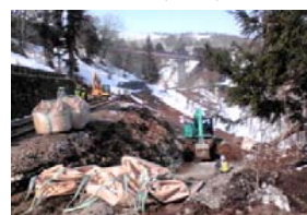
ス.【盛土流失(飯山線 横倉～森宮野原間) 復旧前
