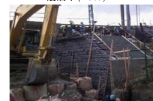
オ.【土留壁倒壊・盛土流失(東北貨物線 長町～宮城野間) 復旧前
