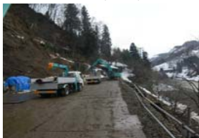
シ.【切取崩壊(飯山線 足滝～越後田中間) 復旧前
