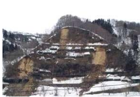
シ.【切取崩壊(飯山線 足滝～越後田中間) 復旧前
