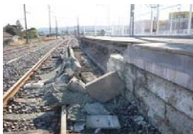
コ.【ホーム擁壁倒壊(常磐線 常陸多賀駅) 復旧前
