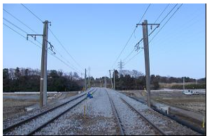
復旧後(3/23施工完了)
