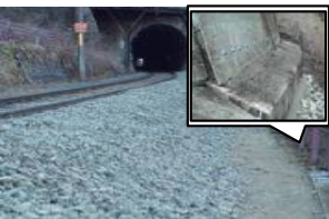
キ.【土留壁傾斜・道床流失(奥羽本線 庭坂～赤岩間) 復旧前
