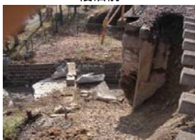
オ.【土留壁倒壊・盛土流失(東北貨物線 長町～宮城野間) 復旧前
