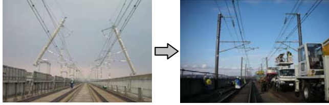
4.【高架橋柱の損傷(新花巻～盛岡間)】
