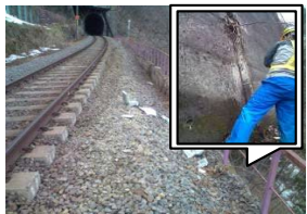
キ.【土留壁傾斜・道床流失(奥羽本線 庭坂～赤岩間) 復旧前
