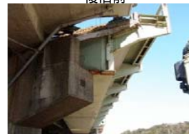
サ.【橋桁のずれ(鹿島線 延方～鹿島神宮間) 復旧前
